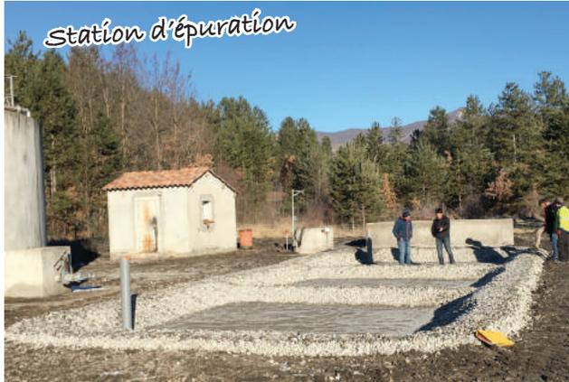
A la station d'épuration du village route de Sisteron, réfection du ruisseau sur 50 m pour l'écoulement des eaux claires, création de bacs d'épandage des boues pour une mise aux normes. Travaux réalisés par l'entreprise POLDER TP de LAZER.
